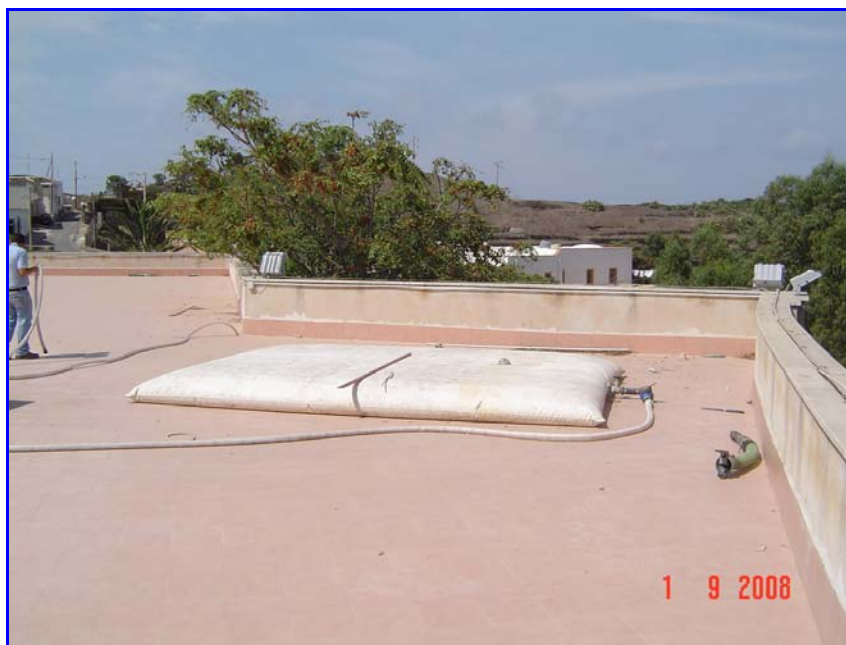
Ubicazione del carico sul solaio di prova
