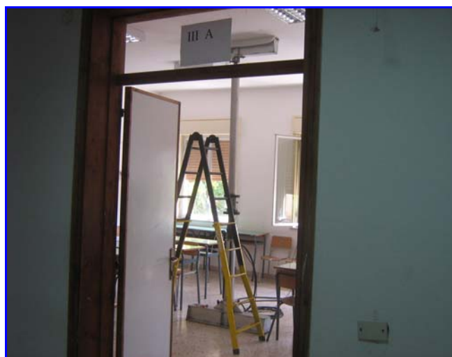
Solaio sottoposto a prova
