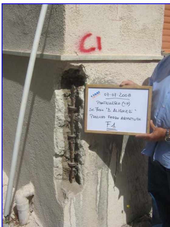
Particolare dei ferri d'armatura prelevati
